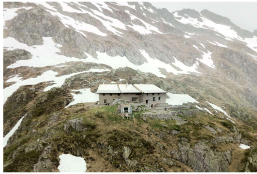
Südfassade mit Terrassen
